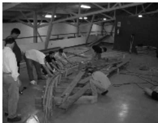
Fig. 9 – Molde para execução dos arcos
