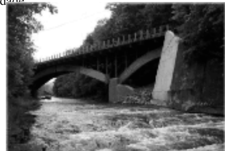
Fig. 1 – Arco abaixo do tabuleiro
