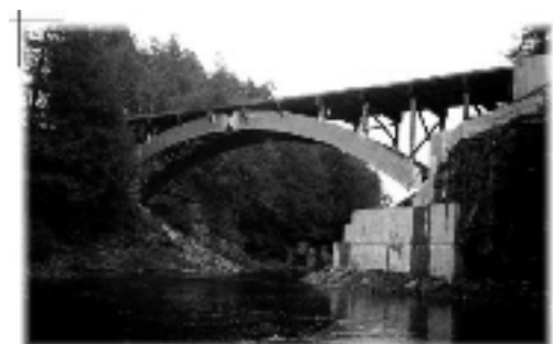
Fig. 2 – Arco abaixo do tabuleiro
