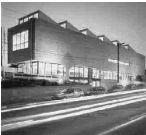
Figura 5 – Cobertura com Sheds – Biblioteca Pública (José
