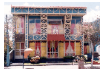
Figura 03 – Sede da Associação Comercial após a remodelação.
